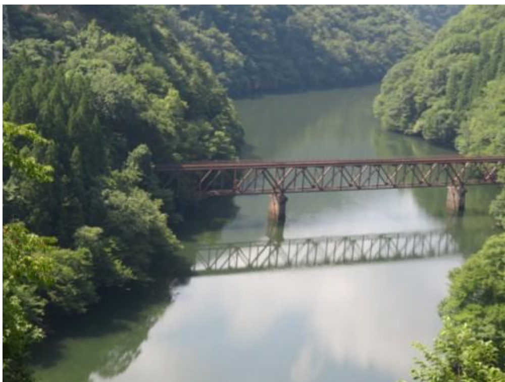
※第三只見川橋梁
